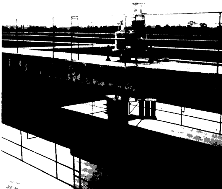
Foto 6 — Tanque de aeração com um dos AMS
