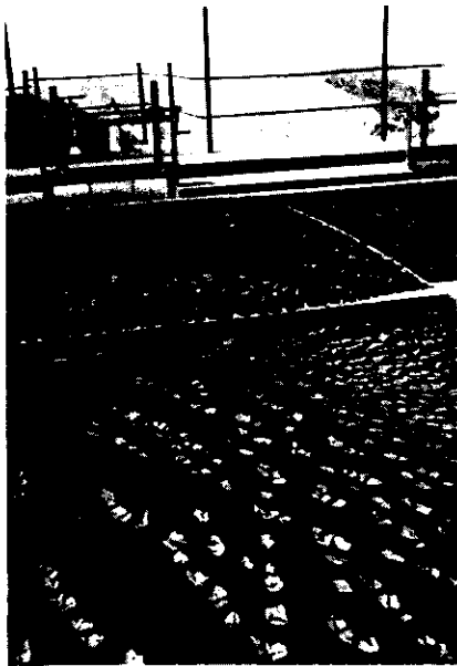
Figura 3 — Flocculador coberto com carvão em pó
