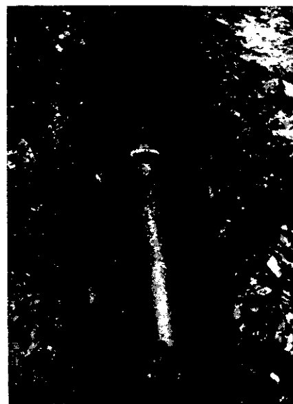
Foto 6 — O recobrimento da rede, com os cuidados para evitar-se abalos nas juntas
