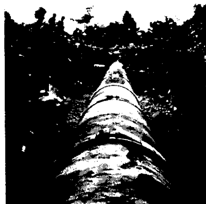
Foto 3 — Sequência de abraçadeira tipo reparo, instalada num trecho de tubulação
