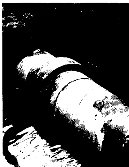
Foto 16 — Conserto numa linha de concreto, diâmetro 710 mm, com abraçadeira de reparo 2
