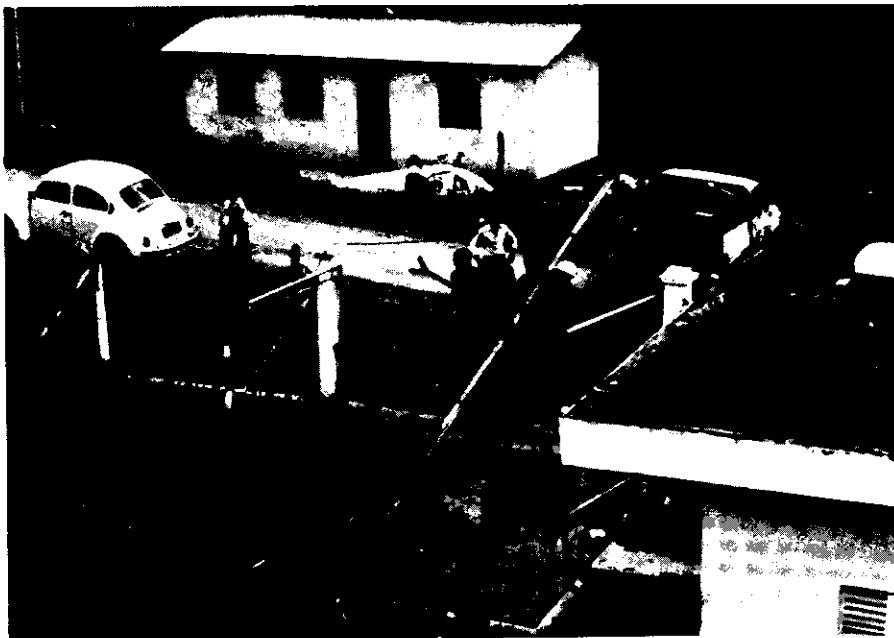
Fig. 11 — Levantamento manual do guincho a fim de se atingir sua posição vertical
