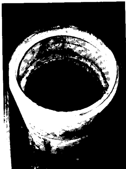
Figura 11 — Anéis de concreto na construção de um poço de visita
