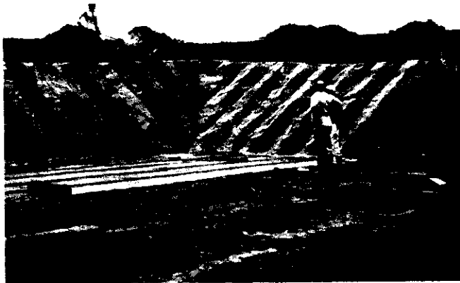
Detalhe da colocação da membrana impermeabilizante
