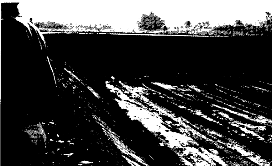
Detalhe da execução dos diques de terra
