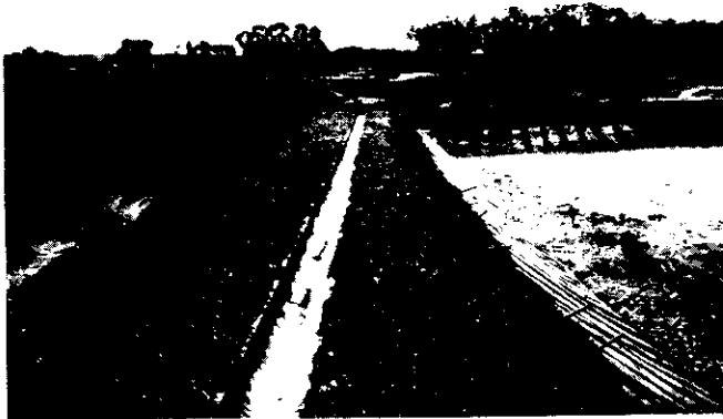
Vista parcial do Sistema de Drenagem Superficial
