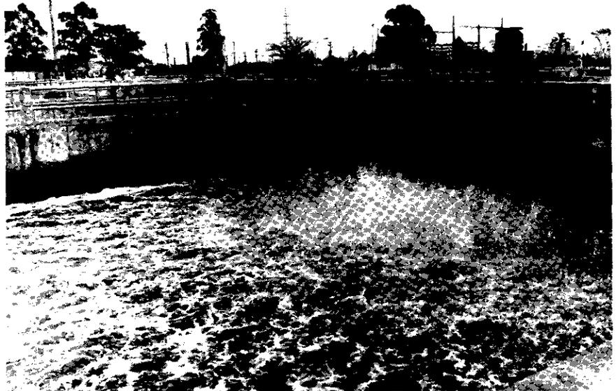
Tanques de aerção, vendo-se a ação de um aerador superficial.
