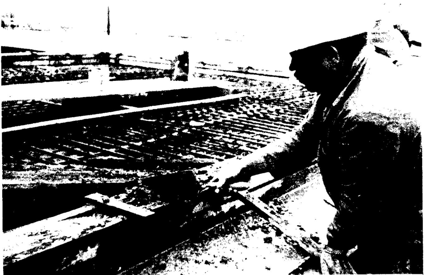
FOTO 11 – Concretagem da laje de cobertura.
