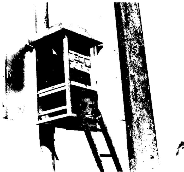
Foto 2 – Retificador de Proteção Catódica por Corrente Impressa.
