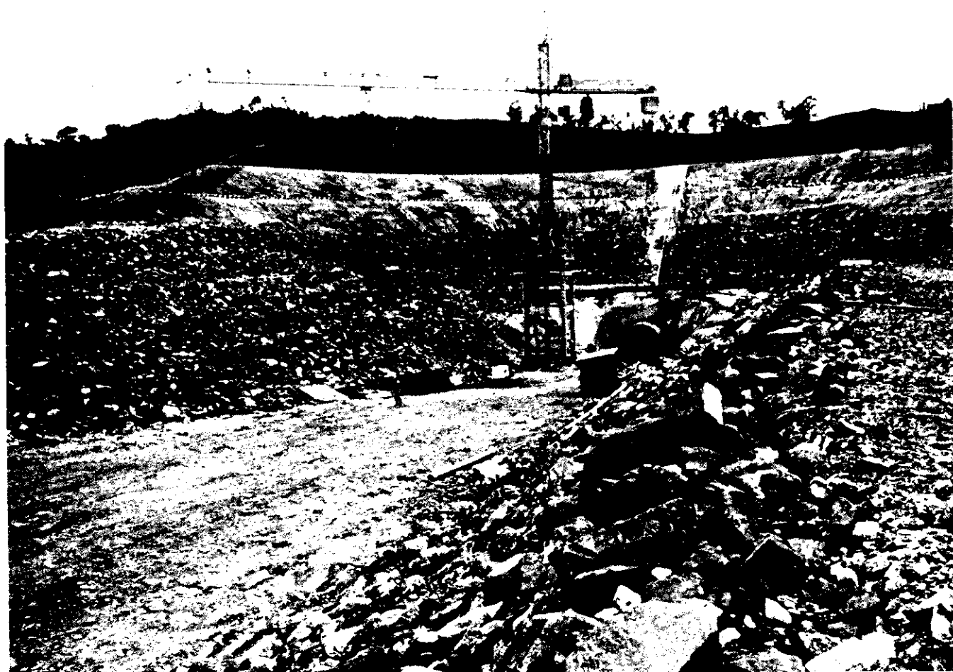
Túnel n.º 7 — Vista geral do emboque, em outubro de 1979.
