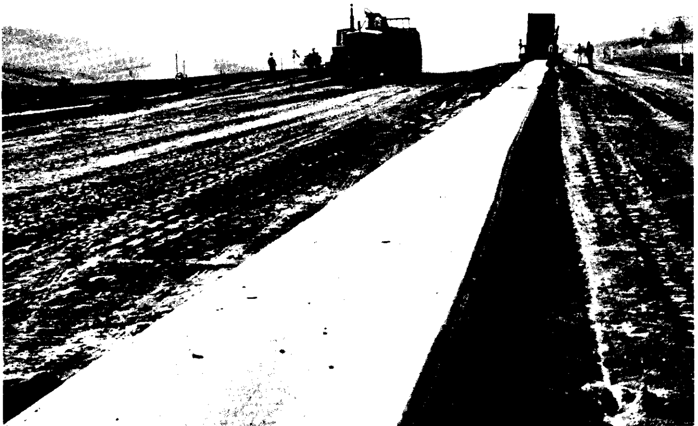
Barragem do Jacarei — Filtro vertical de areia, em 21/07/80.
