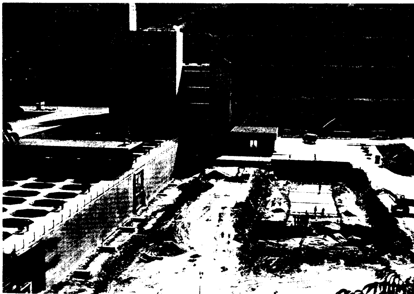
ETA — Guarãú — Fundações da 2.ª bateria de 16 filtros, etapa de 22 m 3 /s, em 28/07/80.
