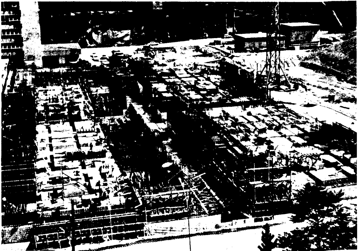
ETA-Guarau — Concretagem da 2.ª bateria de filtros, em 13/03/81.
