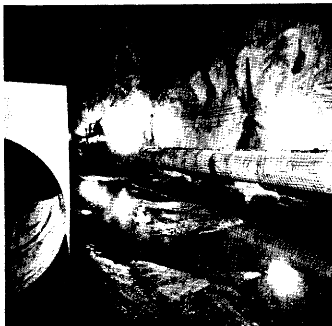
Câmara do lado do Emboque Santa Tereza – Santos concretagem da envoltória da tubulação do extravasor
