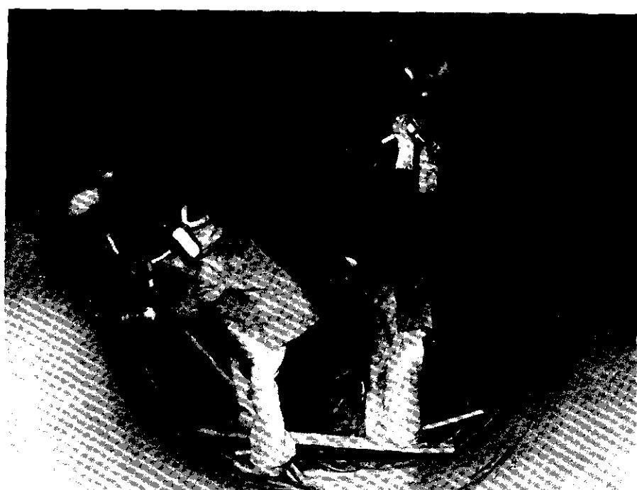
Confecção de junta de campo em tubulação de aço (D = 1,80 m) do Sistema Adutor Metropolitano, após a verificação da respectiva solda, através de raios-X.
