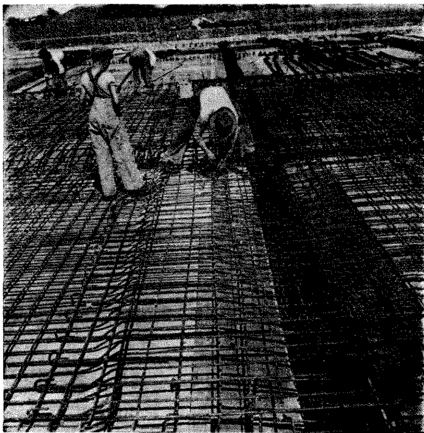
Fotog. 7 — Reservatório de Sant'Ana (C = 16.000 c. m.) Ferragem da lage de cobertura.
