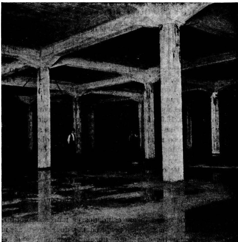
Fotog. 5 — Reservatório de Sant'Ana ( C = 16.000 m. c.) Interior de um compartimento.
