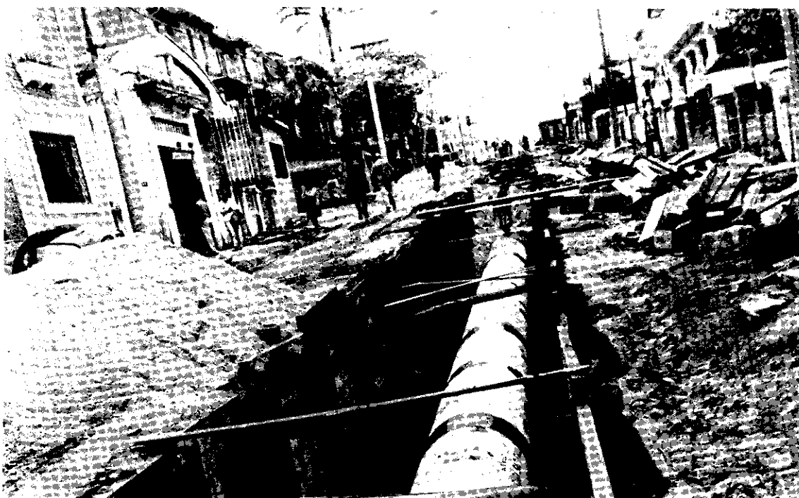
Assentamento do SAM — Sistema Adutor Metropolitano.
