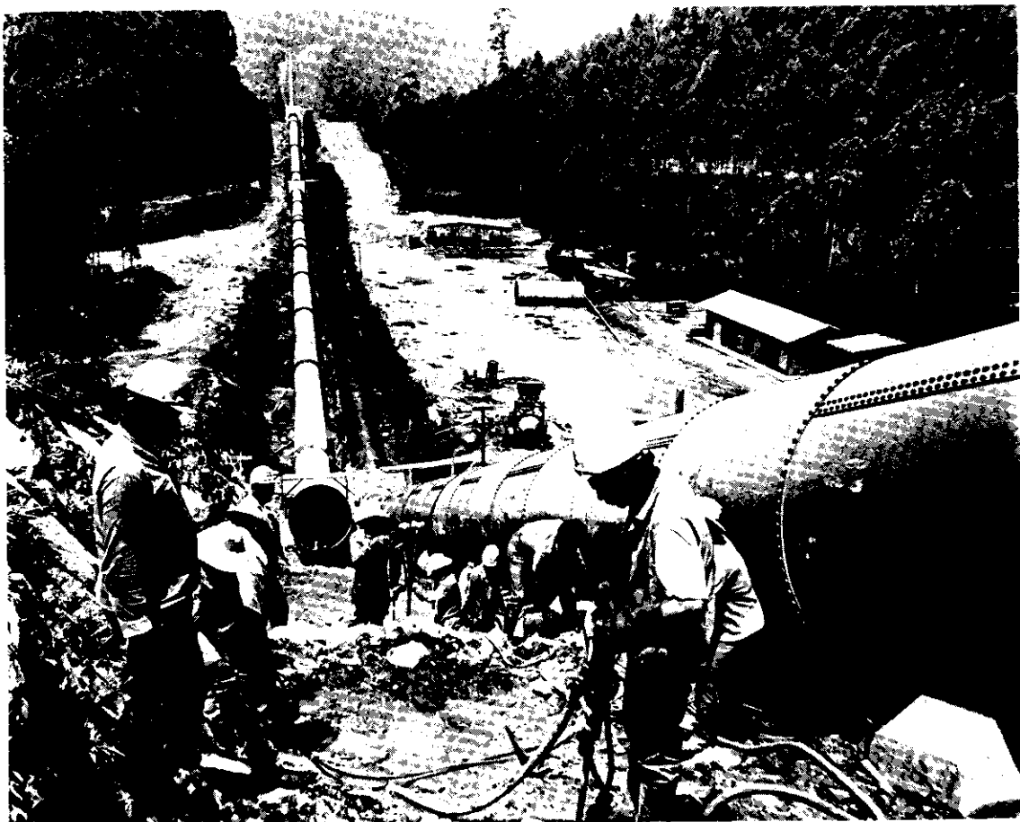
Duplicação da Adutora Rio Claro.
